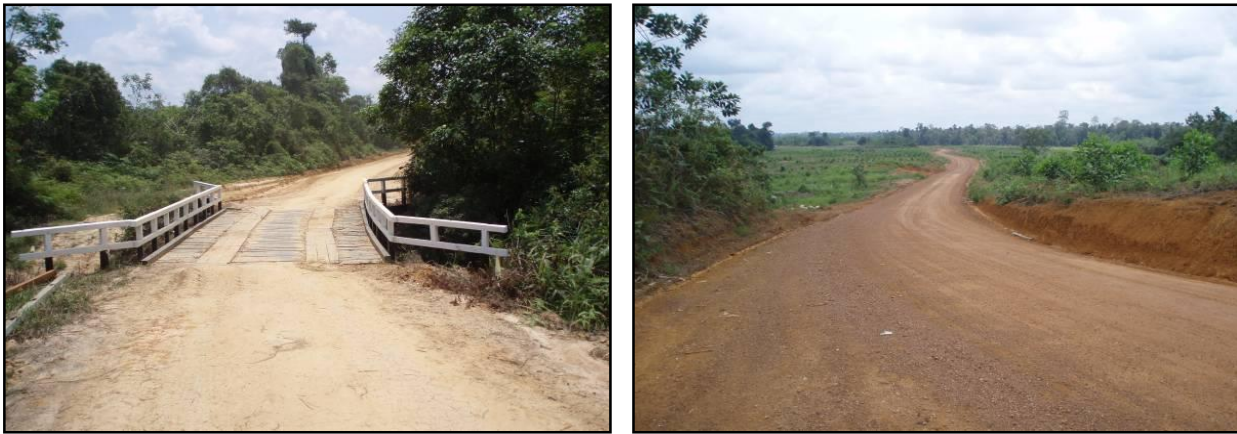
Gambar 1. Pembangunan sarana jalan dan jembatan di areal PT FI
